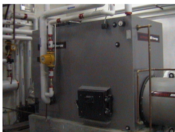
Rys. nr 3 Kocioł z automatycznym podajnikiem paliwa. Rys. nr 4. Podajnik paliwa
