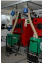
Rys. nr 2 Kotłownia (2 kotły po 200 kW)
