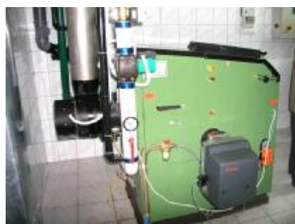
Rys. nr 6 Kocioł opalany biomasa dodatkowo wyposażony w palnik olejowy- Siemianowice
