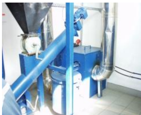
Rys. nr 5 Instalacja automatycznego usuwania popiołu
